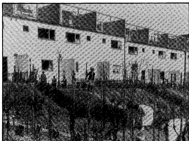
Ill.18 Förebildlig radhusarkitektur i Siedlung Praunheim, Frankfurt am Main.
